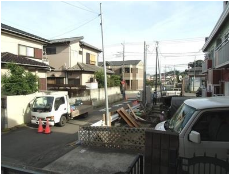
(16:32 家の前 水路の側壁修繕)
