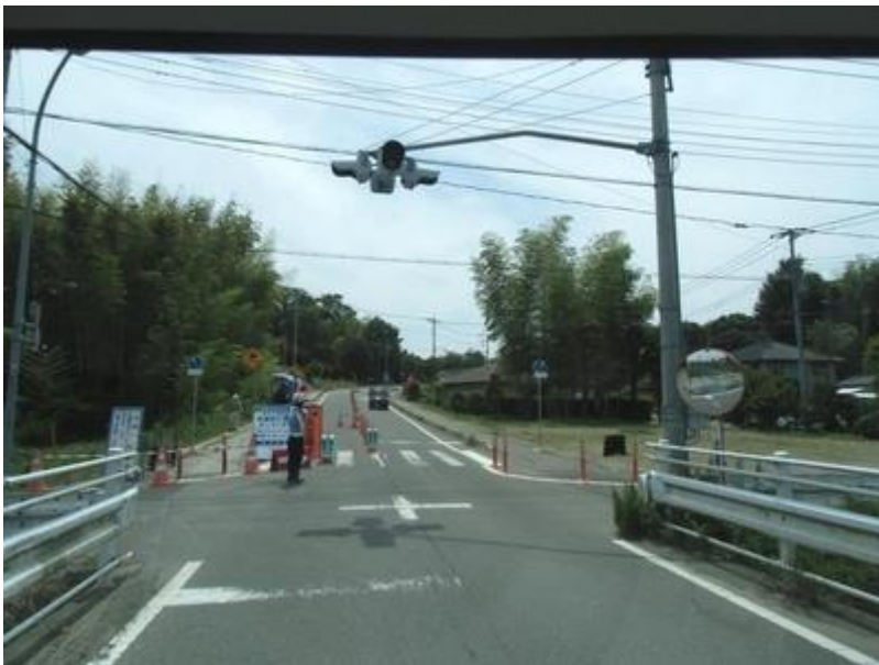
(12:50 岡 これもガス管)
