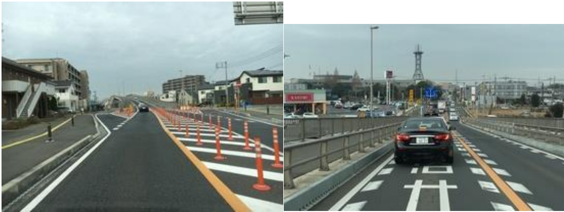
(JR常磐線を跨ぐ「藤代陸橋」。「藤代庁舎東」交差点で、旧国道6号と交差)
