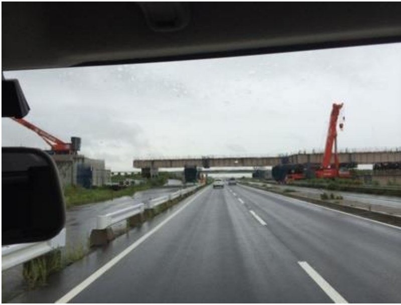
( 8/17 8:06 国道 294 号, 常総市内・圏央道建設中。)
